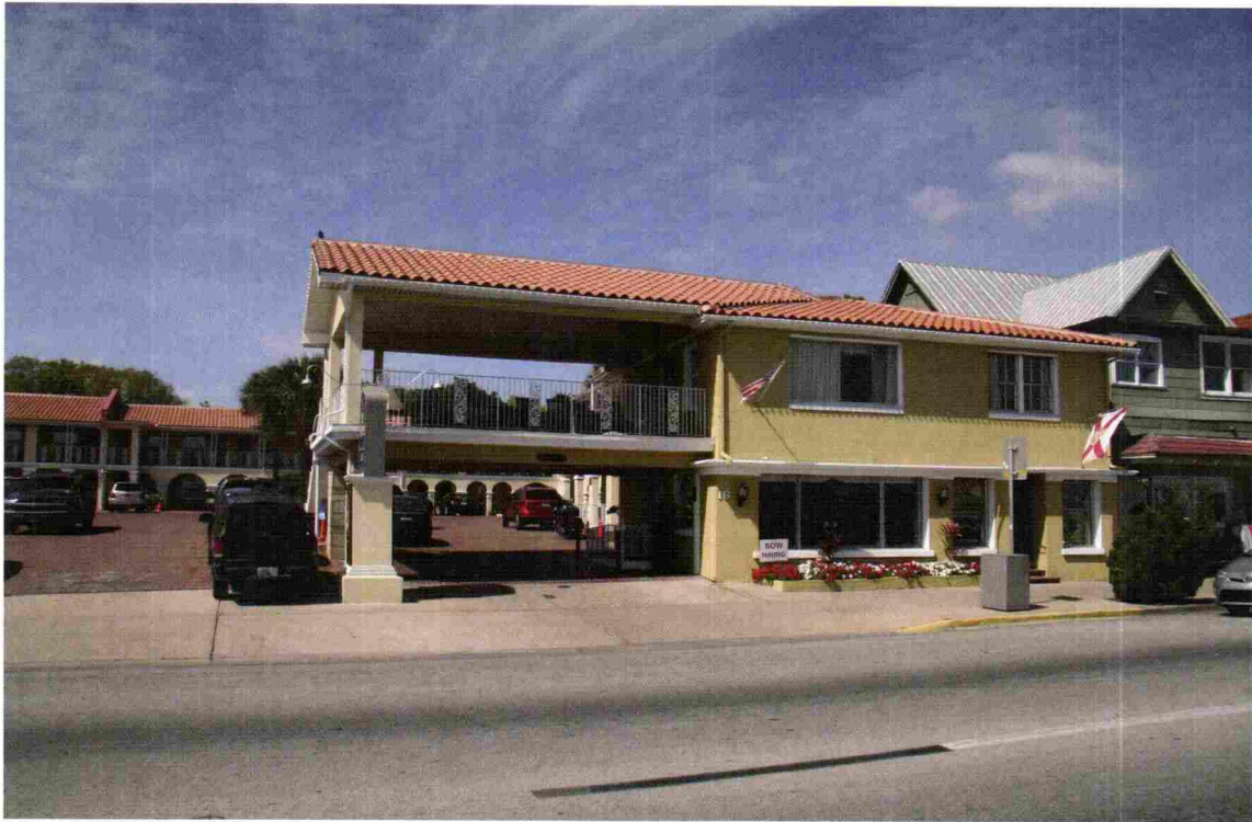
8SJ05588_a Facing West.JPG
