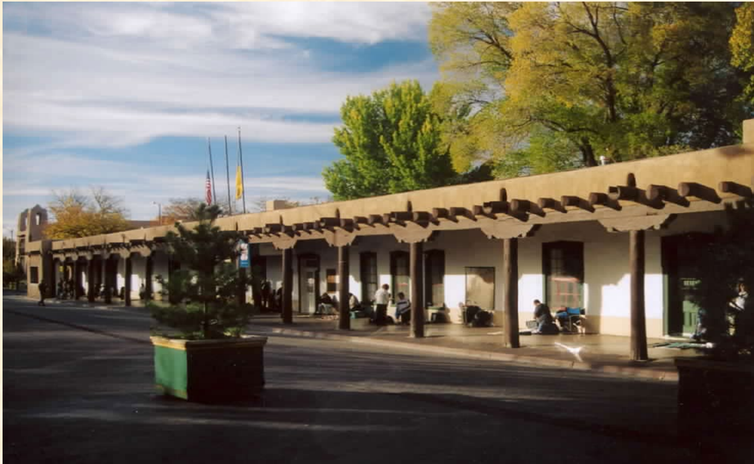
FIGURE 21 PALACIO DE LOS GOBERNADORES, SANTA FE, NEW MEXICO
